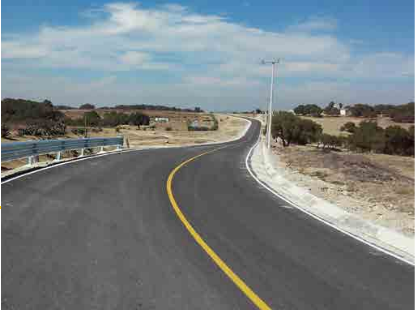
Carretera alimentadora, Guerrero <<
