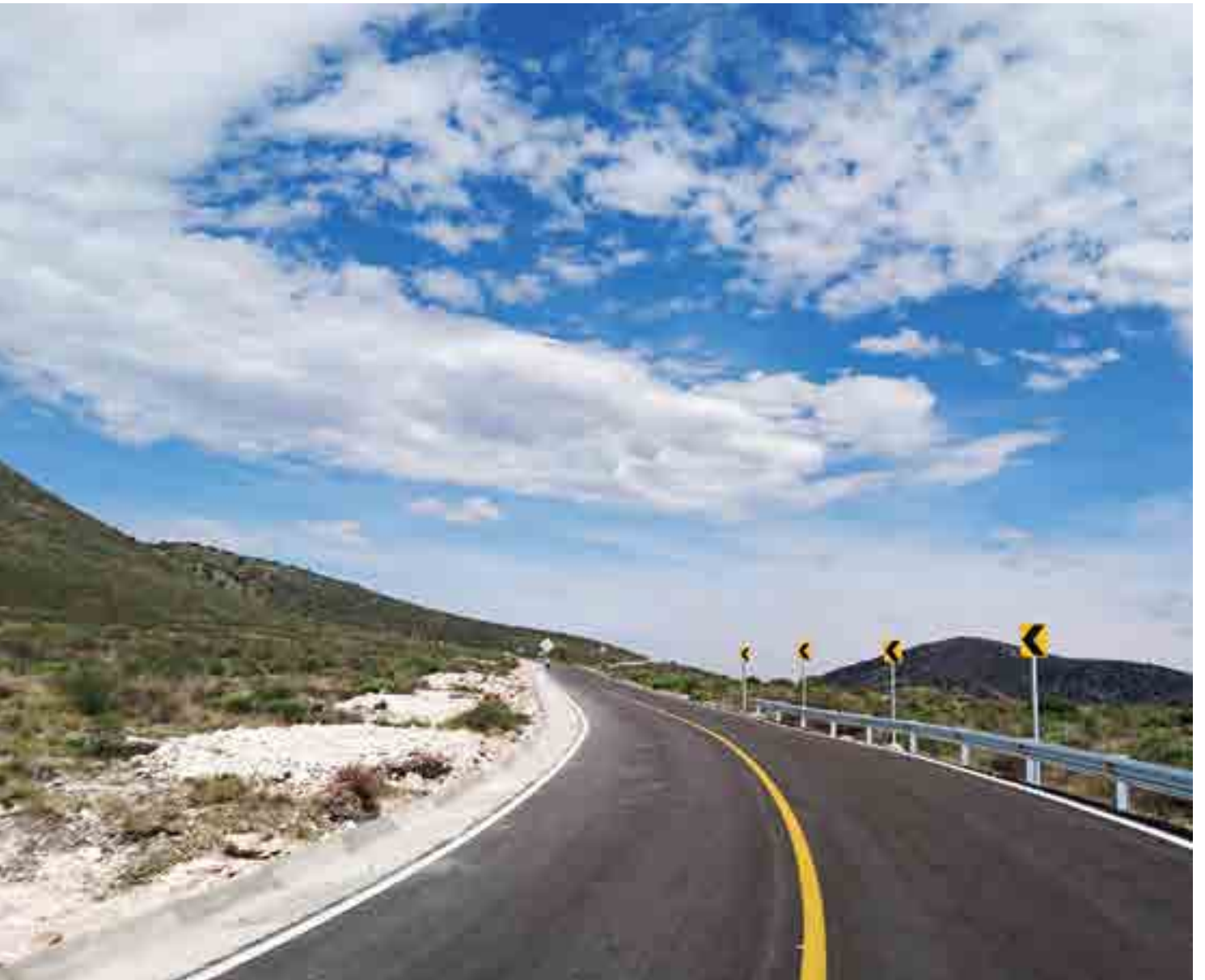
Carretera alimentadora, Hidalgo <<
