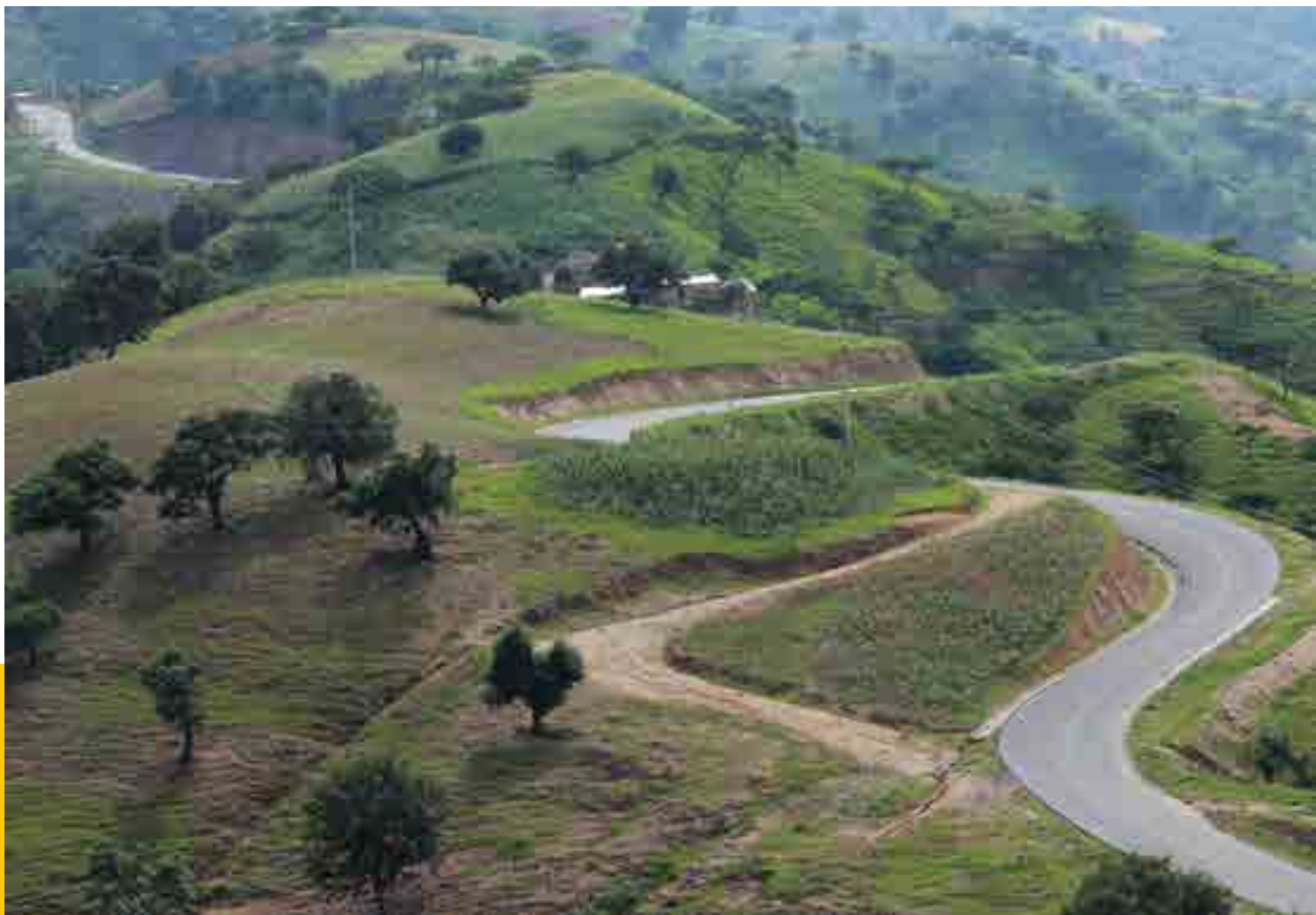
»» Carretera alimentadora, Guerrero
