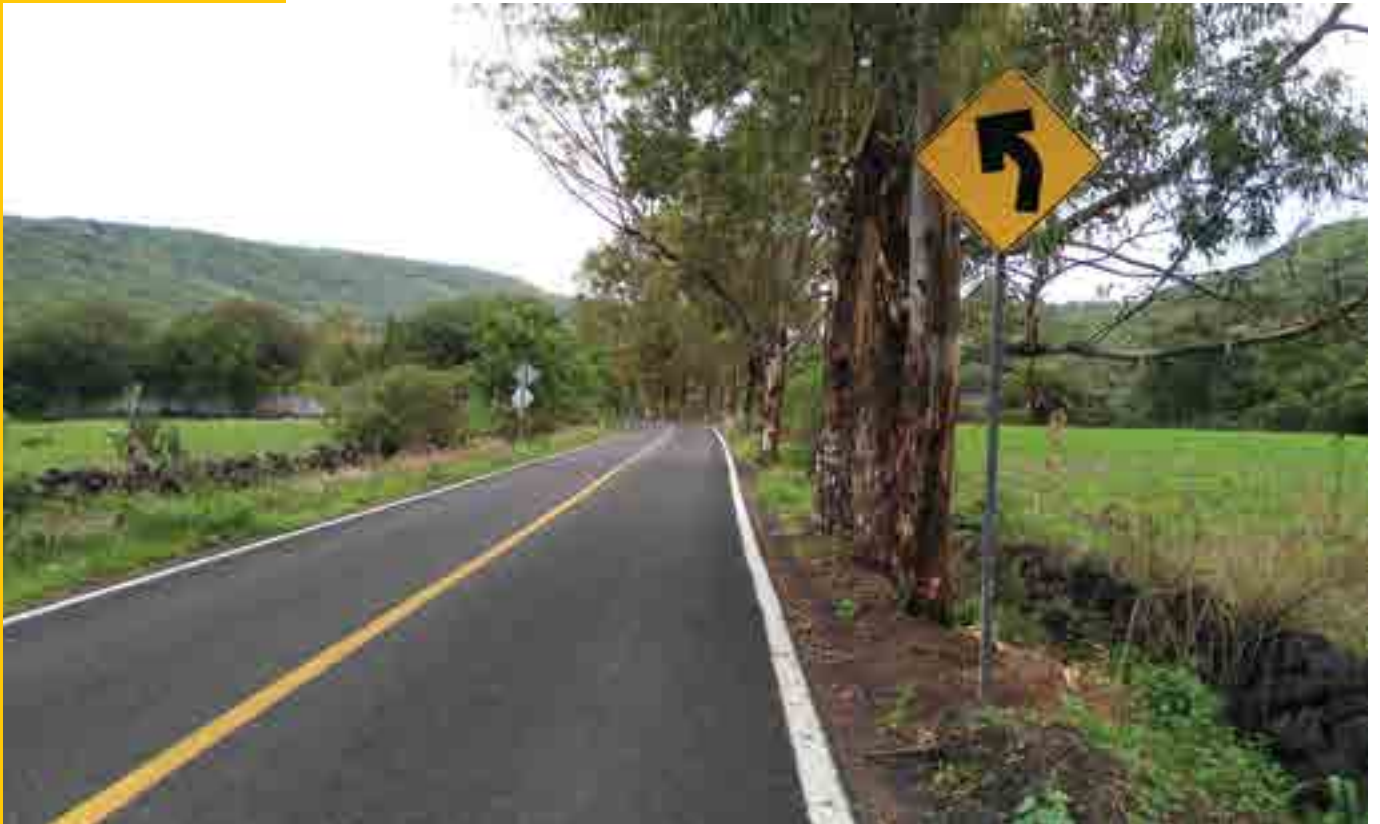
Carretera alimentadora, Guanajuato <<
