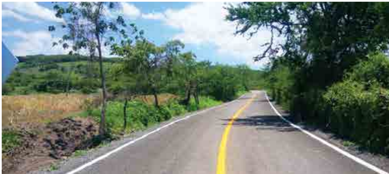
Carretera alimentadora con base hidráulica y un riego de sello, Jalisco <<
