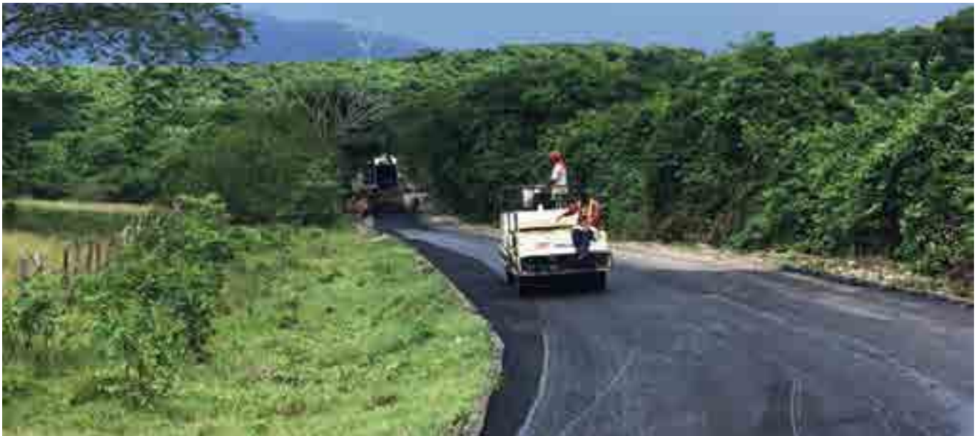
Colocación de carpeta asfáltica, Jalisco <<
