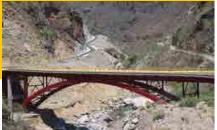
Puente en carretera alimentadora, Chihuahua <<
