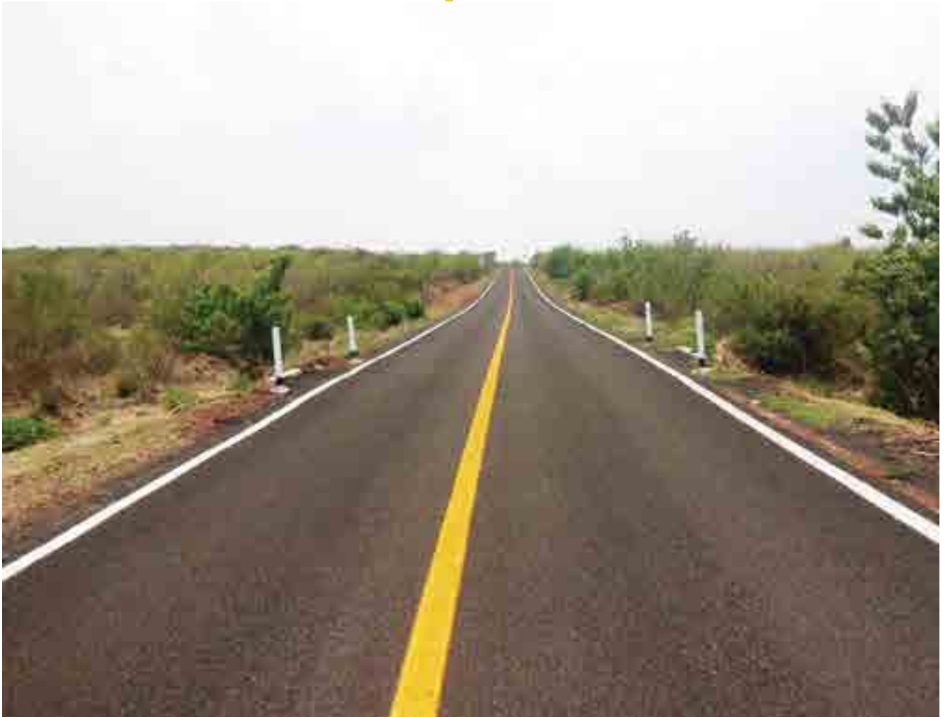
Carretera alimentadora, Hidalgo <<
